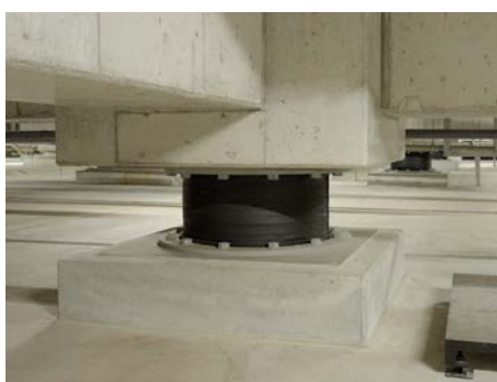
地下には79基の免震装置が並び、建物を地震から守っています。
